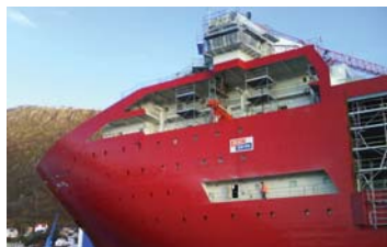
Byggingen er i full gang
